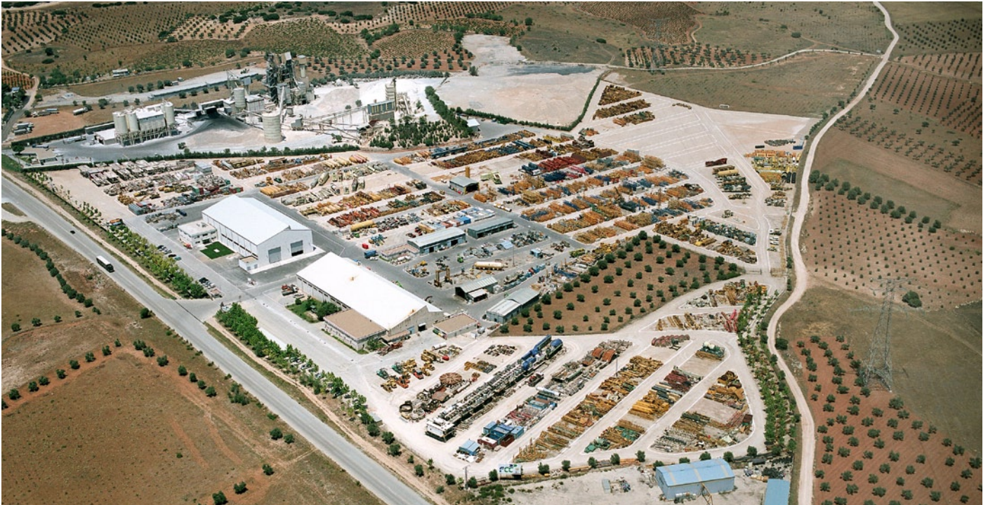
FCC Construcción's Machinery Pool
